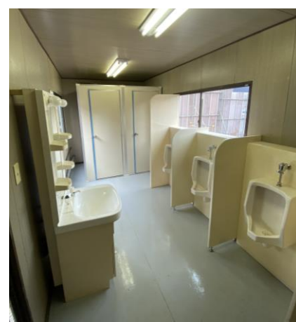
※ユニットハウス内へ設置
